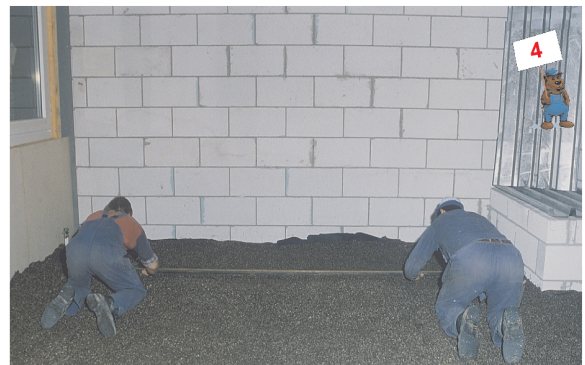
Oberflächenglattes Abziehen von VERMIBIT.
