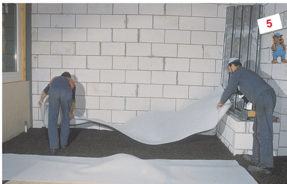
Wellkarton (oder für verbesserten Trittschall Weichfaserplatte 10 mm) verlegt, verhindert das Eindringen der Körner in die Fugen der Bodenverlegeplatten.
