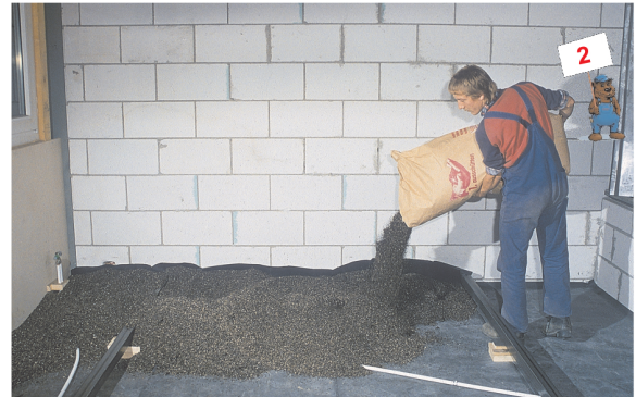
Schütten und verteilen, Mindesthöhe 20 mm.
