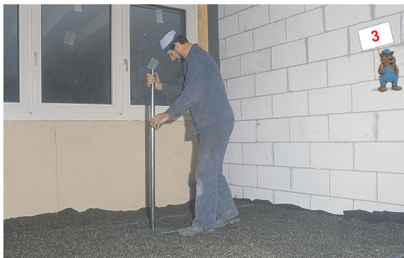
Verdichten der Schüttung ca. alle 4 cm, z. B. mit einem Rechen, Stampfer oder Brettschuhen um ca. 10-15 %.
