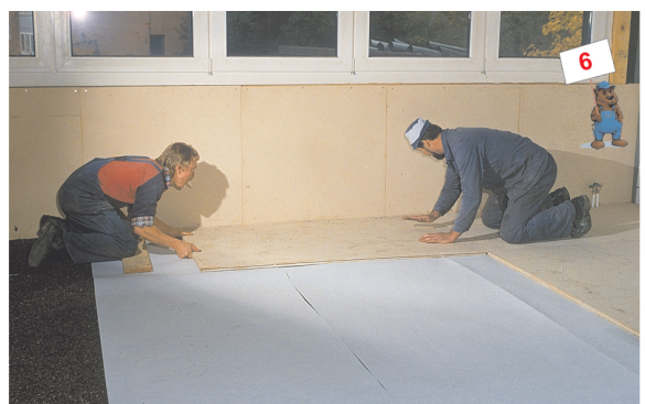
Verlegen der Bodenverlegeplatten von mind. 22 mm, resp. Gipsplatten mind. 2 x 10 mm.
