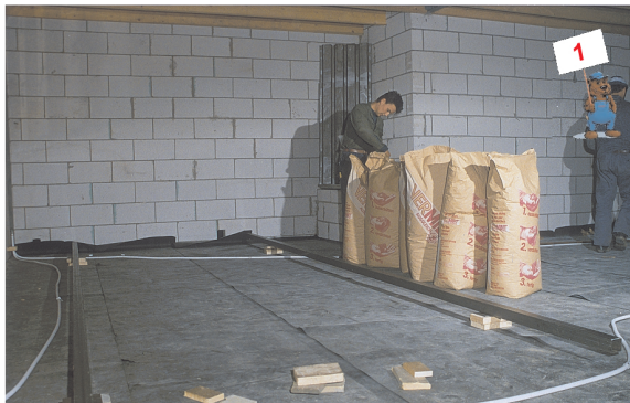
Setzen der Abziehlen z. B. auf VERMIBIT.
