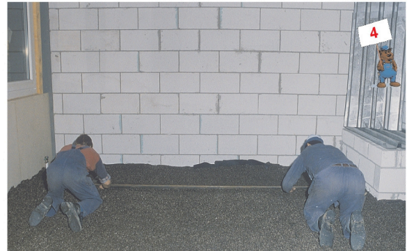
Oberflächenglattes Abziehen von VERMIBIT.
