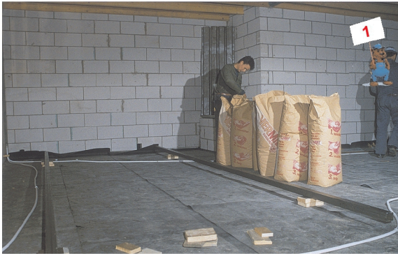
Setzen der Abziehlen z. B. auf VERMIBIT.
